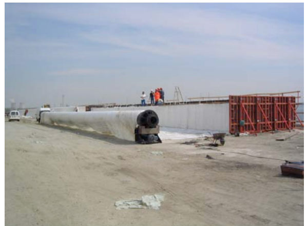
Foto 2: Oprollen geotextiel met lengte 100m en breedte 30m, plus 2,5m overlap, op stalen koker.
