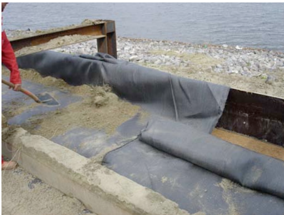
Foto 11: Aan de buitenkant van het frame wordt het geotextiel voorlopig over geplooid.
