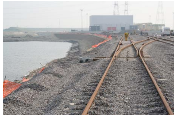
Foto 14: De aanleg van de spoorwegbundels op de gewapende aarde. Let op de bocht die de muur maakt volgens de segmentenlijn
