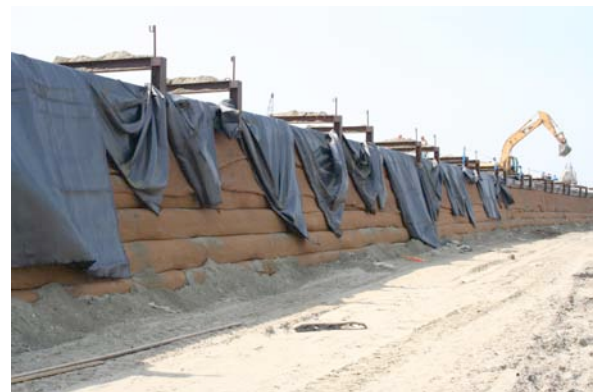
Foto 11: De overgevloeiende geotextielen zullen na aanvulling en verdichten van het zand achter het frame worden teruggeplooid.
