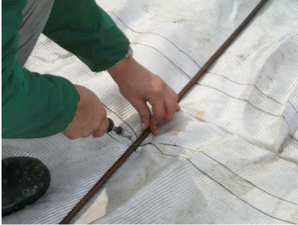
Foto 3: Vastmaken betonijzers aan geotextiel bij middel van ingeweven lussen.
