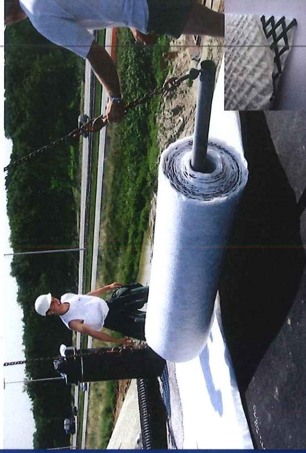
**Geocomposit in polypropyleen met mini-drains voor drainage, Quesnoy (FR)**
