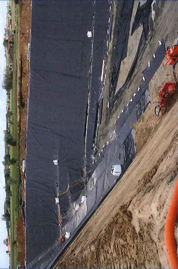
**Geocomposiet bentoniet (PP + klei), geomembraan (HDPE), geocomposiet drainage (PP) Huidenberg (BE)**
