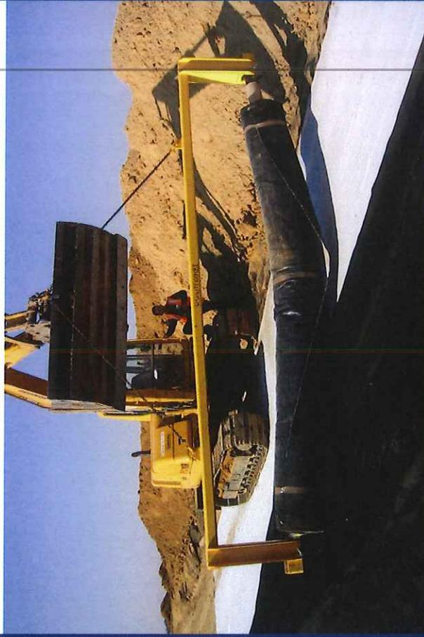
**Geotextiel (PP) met elektrische lek detectie (1985) ELDEG, Lokeren**
