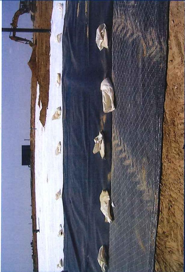
**Afdichting met geocomposiet bentoniet (PP + klei), Bertrée (BE)**
