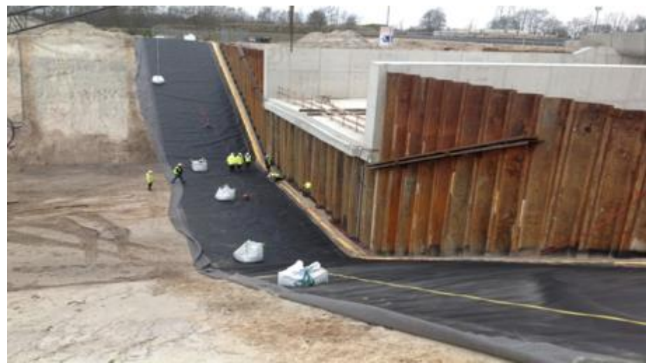
● Aansluiting damwand
