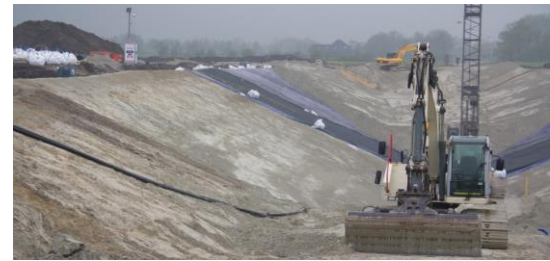
• Aanbrengen ballastlaag
