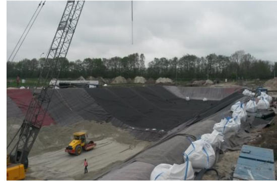
• Aanbrengen ballastlaag
